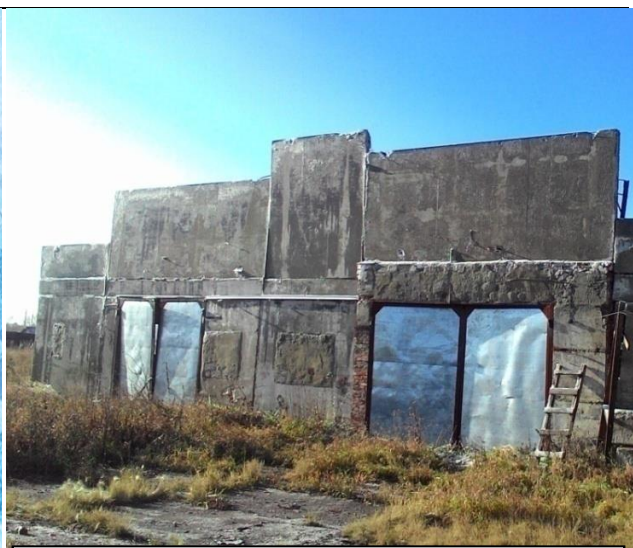
1. Здание гаража арочного типа
